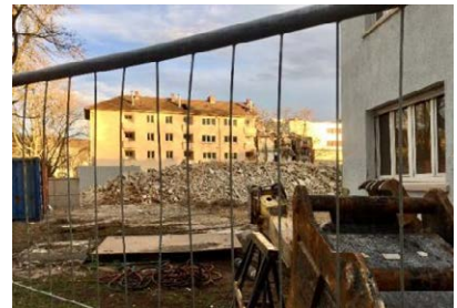
Foto beim Abriss: Stephanie Breidenstein
