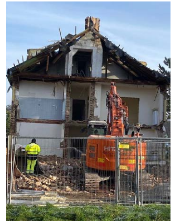
Fotos vorher/Abriss: Annette Hüdepohl
