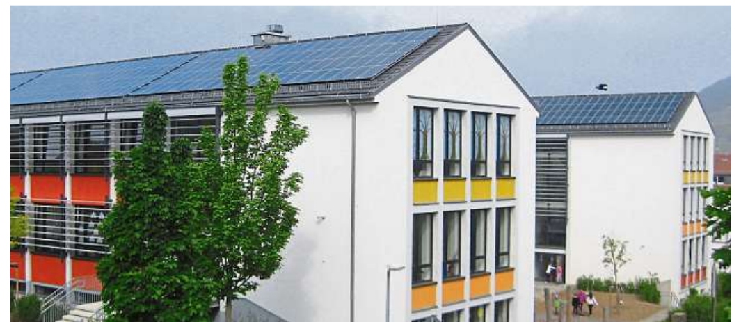
Das Dach der Grundschule an der Burg Klopp ist mit Fotovoltaik-Anlagen ausgestattet.
