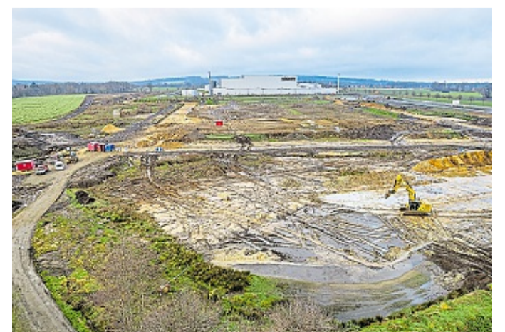
Die Erschließung des Gewerbegebietes an der B218 ist im Gang.
