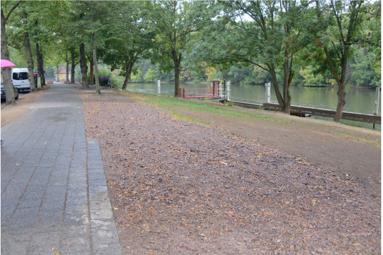
Foto 10: Mit Poprhyr-Schotter abgedeckte Allee-Bereiche.
