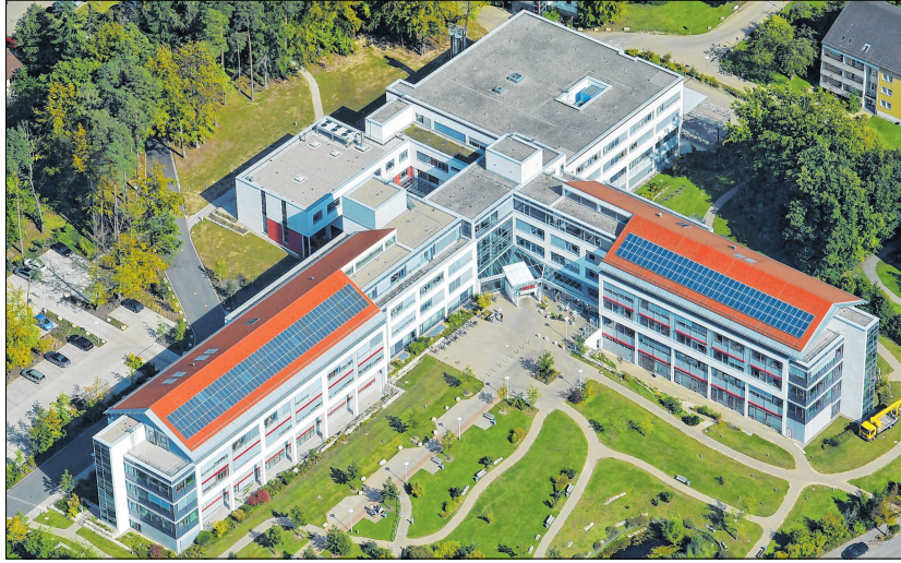
In der Diakoneo-Klinik in Neuendettelsau soll die Notfallversorgung auf dem Schwerpunkt Kardiologie liegen. Foto: Nürnberg Luftbild, Hajo Dietz
