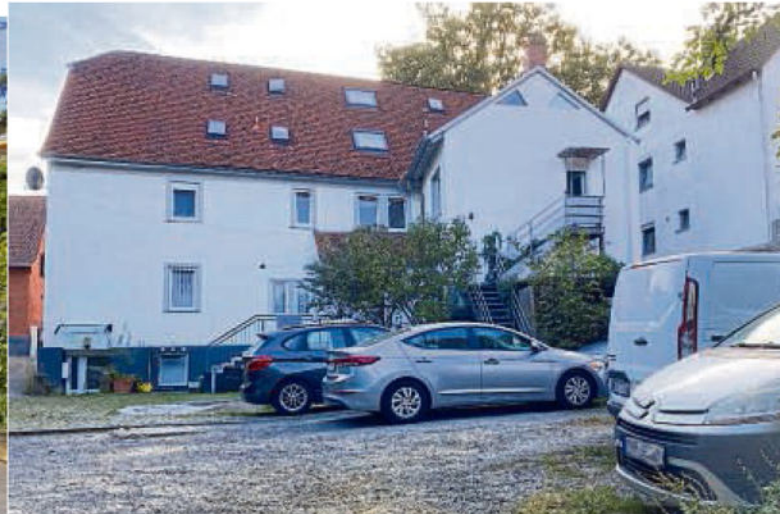
Der ehemalige „Adler“ in der Nachbarschaft – heute ein Wohnhaus.
