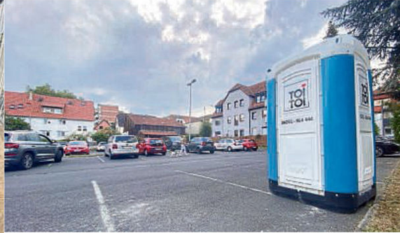
Parken und Pipi? Kein Dauerzustand – einer Baustelle geschuldet.
