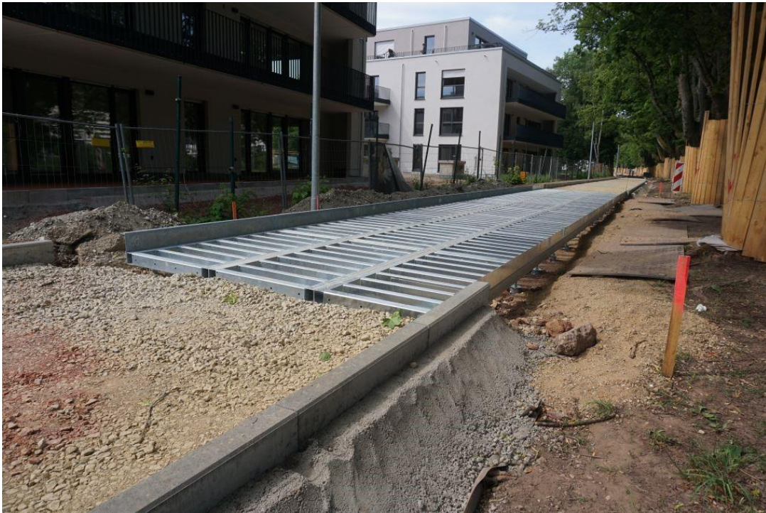
Im Bau auf Erdschrauben
